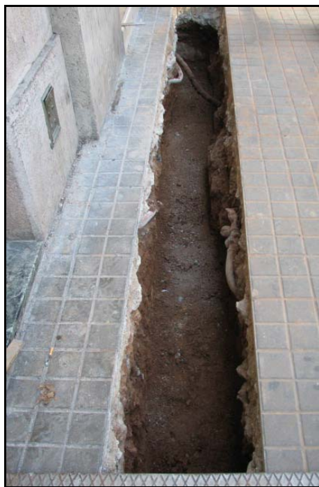
Foto 2: Continuació de la rasa 100.
