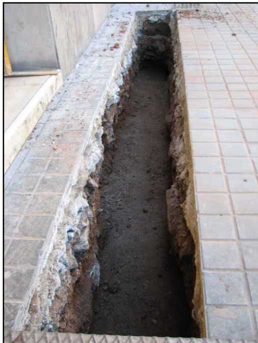
Foto 4: Continuació de la rasa 200.
